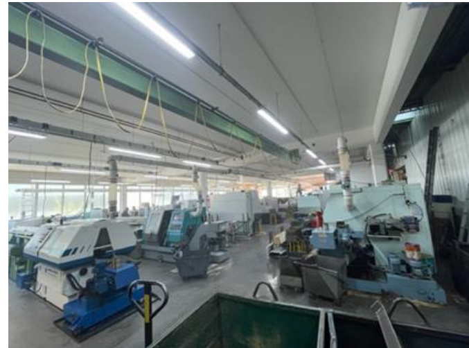
réseau de collecte des BH en cours d'installation -photo TIMS
