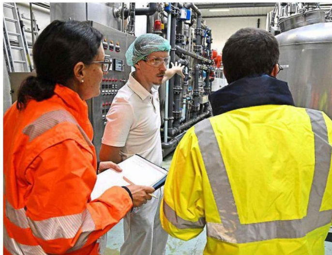
Les inspecteurs ont vérifié les installations permettant de réduire la consommation d'eau de l'usine. | PHOTO : VINCENT MICHEL / OUEST-FRANCE
